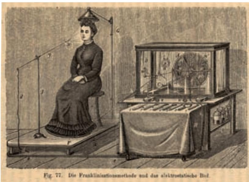
Fig. 77. Die Franklinisationsmethode und das elektrostatische Bad.
